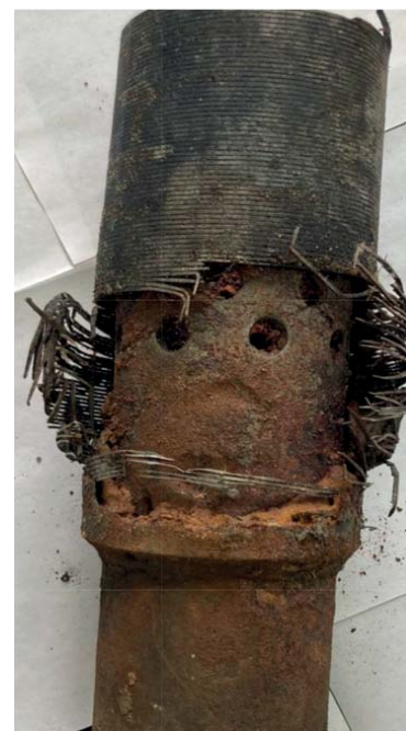
Рис. 2. Результат бактериальной коррозии скважинного фильтра ФСК-89.
